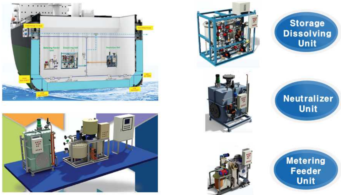
[그림 40] 화학제 주입방식의 대표적인 Component
